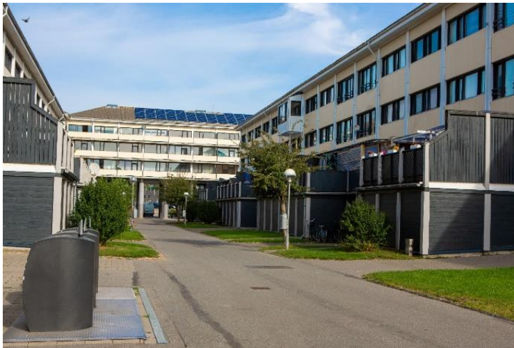
Taastrupgaard FØR reovering
