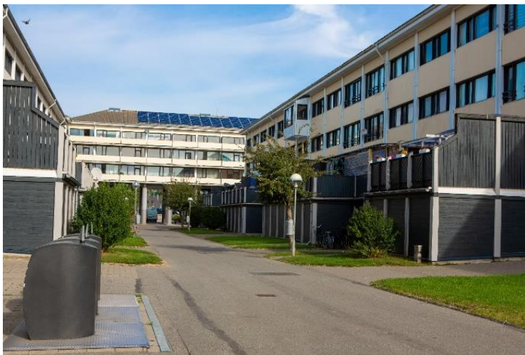
Taastrupgaard FØR renovering
