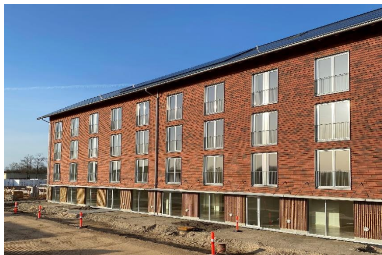
Taastrupgaard EFTER renovering
